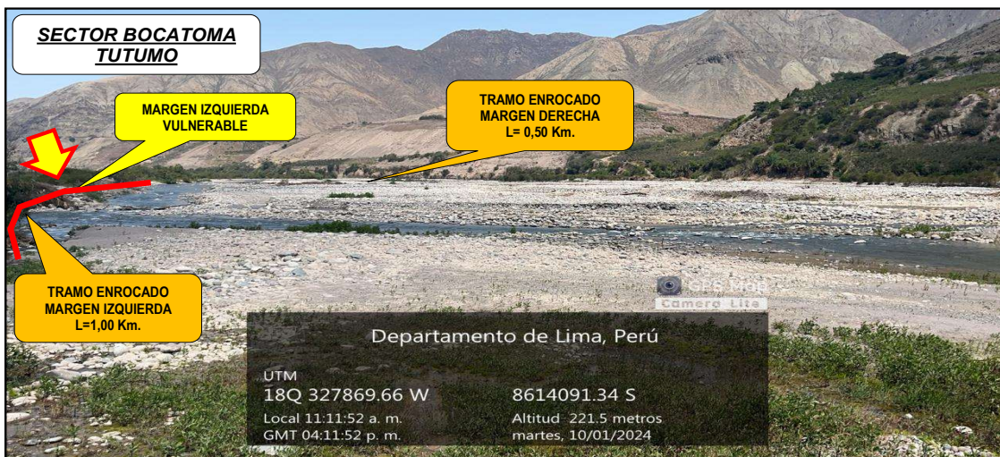
FIGURA N°01: TRAMO CRÍTICO EN EL RÍO MALA , EN EL SECTOR BOCATOMA TUTUMO, DISTRITO DE CALANGO, PROVINCIA DE CAÑETE - LIMA.
